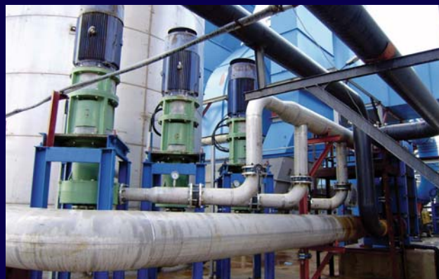
立式泵用于化肥厂的腐蚀性液体
