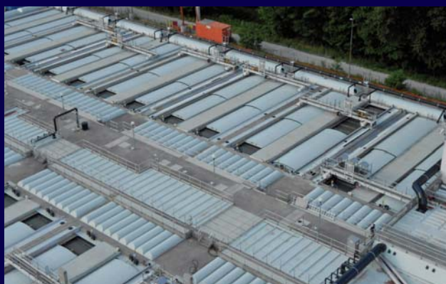
污水处理厂可伸缩式盖板的设计和供应
