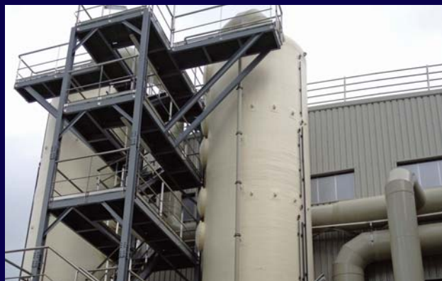
造纸厂采用生物滴滤法的气味控制
