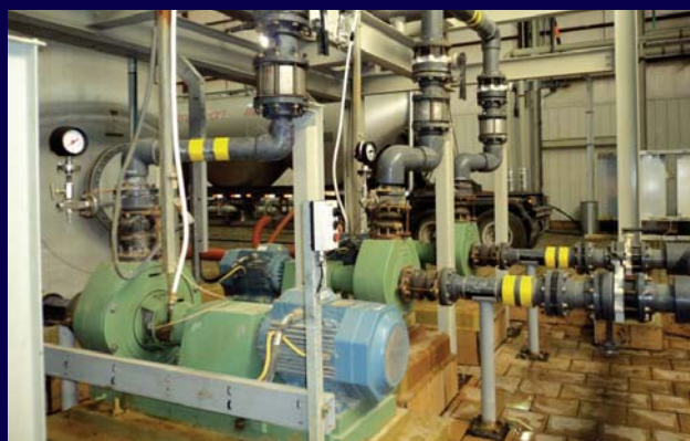
符合EN-ISO 22858的流程泵用于铀矿开采
