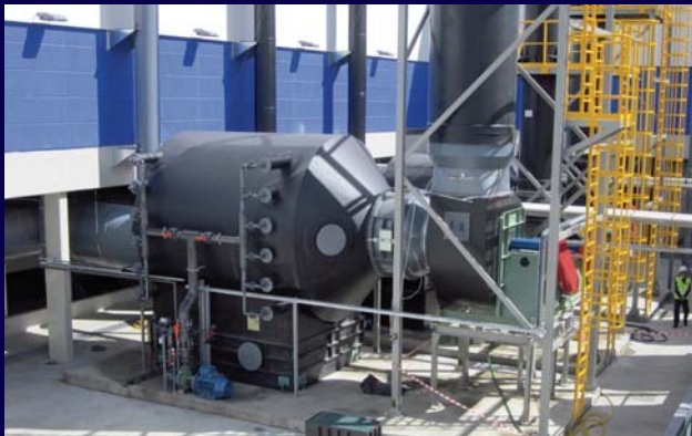
航空航天工业零件镀铬槽的气体清洗
