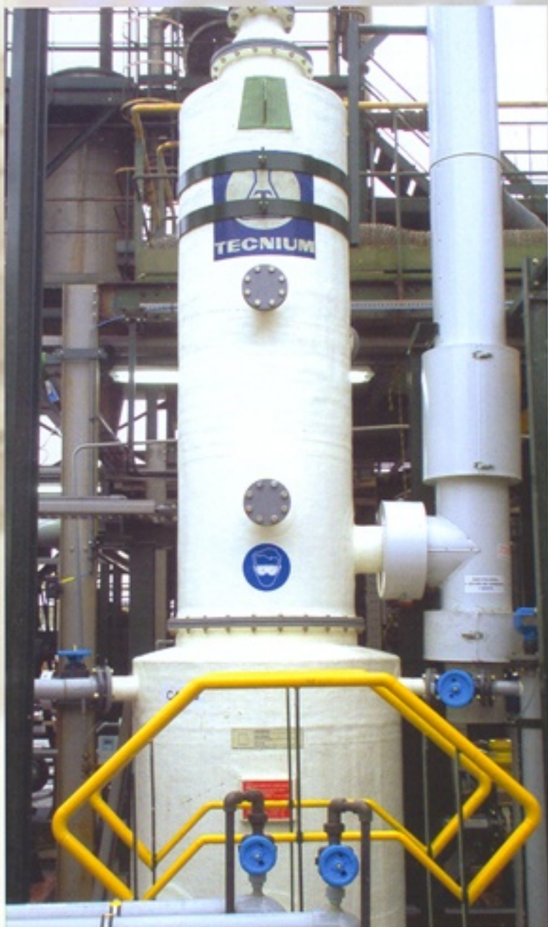
VOC absorption on a pharmaceutical plant in France Absorción de COV para planta farmacéutica en Francia
