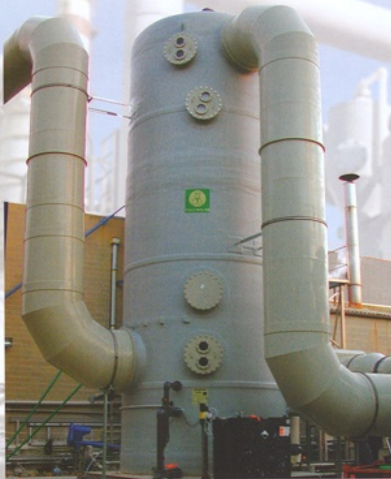
NO x chemical absorption at an Asian chemical industry Absorción química de NO x en industria química en Asia
