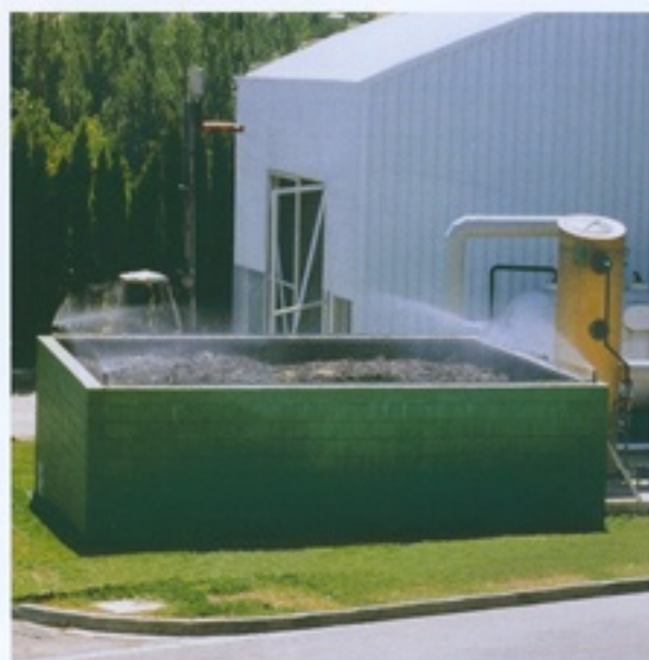
H_2S +VOC biofiltration at a Spanish food plant Biofiltración de H_2S +COV en una fábrica alimentaria española
