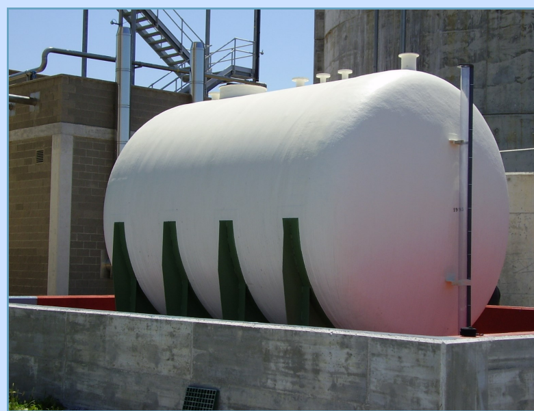
Tanque horizontal para salmuera y HCl
